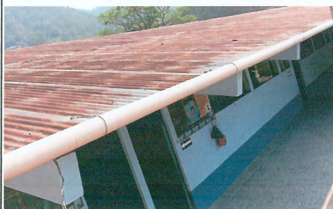
Foto 3: Cubierta delantera, parte externa.
