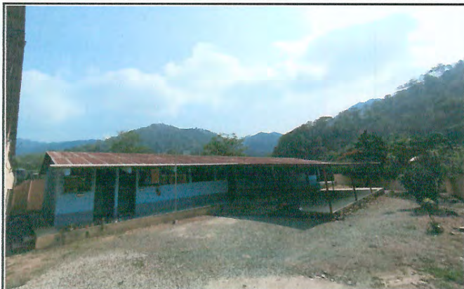
Foto 1: Vista panorámica del techo a sustituir.
